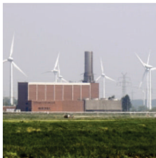
Impianto CAES entrato in funzione nel 1978, Kraftwerk Huntorf
