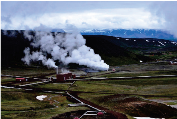
Impianto geotermico in Islanda
